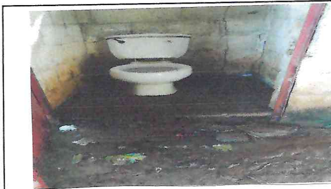
Foto 3: Pared y torta de los baños
