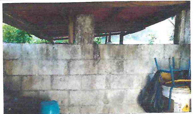
Foto 4: Techo y pared de cocina
